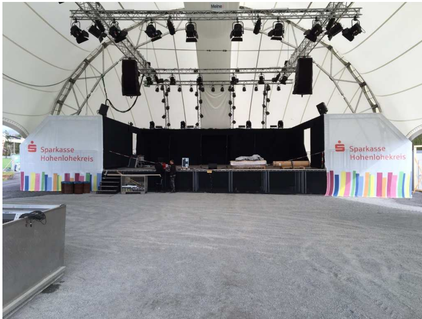
Sparkassenbühne auf der Cappelaue während der Bauphase.
