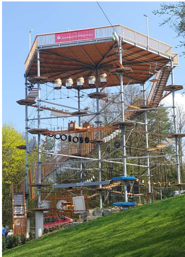
Fertiggestellter Kletterturm mit Sparkassen-Podest am 14. April 2016.
